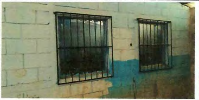
Foto 6: Cambio de pintura en la pared de la escuela.
