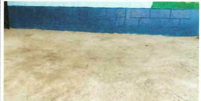
Foto 4: Cambio de piso por cerámico en el corredor de la escuela.
