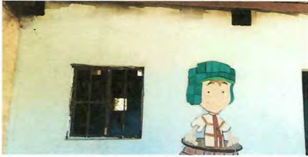
Foto 1: Ampliación de ventana y colocación de balcón.
