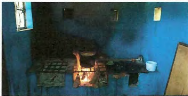
Foto 3: Ampliación, colocación de cerámico y cambio de plancha por uno mas ancho y largo.
